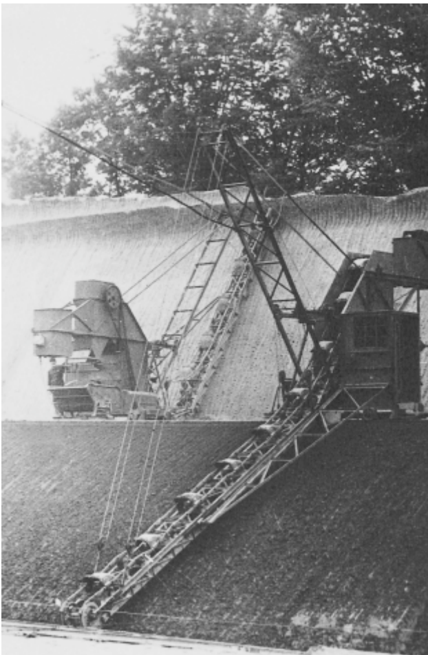
Eimerkettenbagger in der Lehmgrube von Orthaus und Tacke 1954
