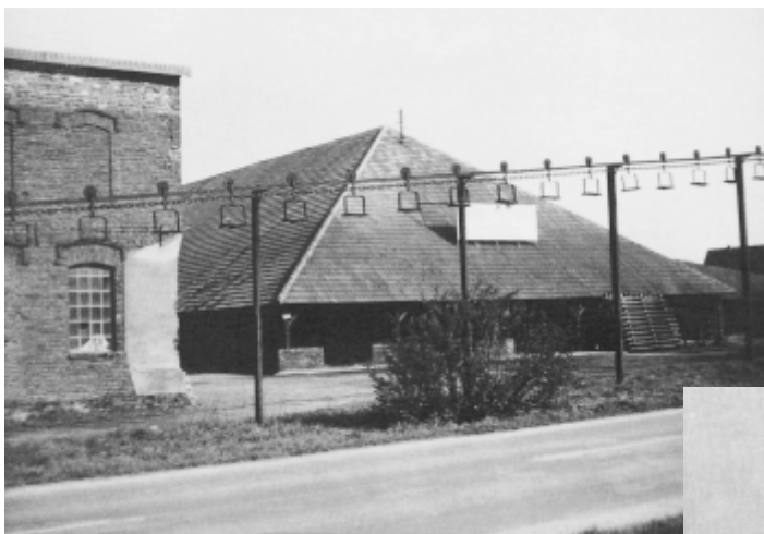
Ansicht von der Dingener Straße
