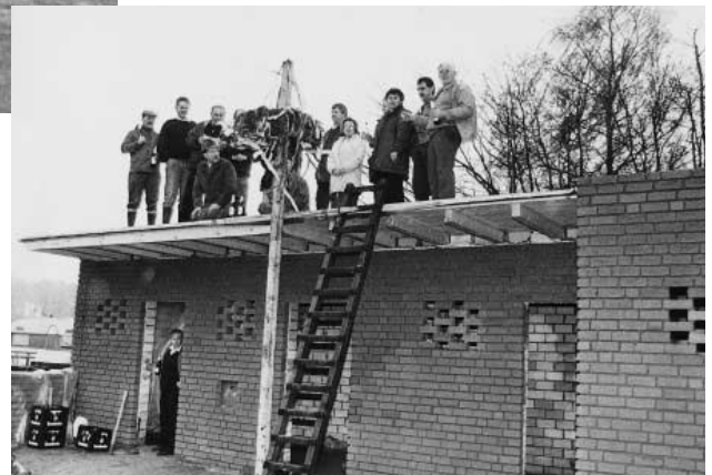
... und Richtfest der Toilettenanlage
