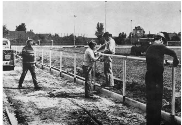
Bau des neuen Sportplatzes im Juni 1974
