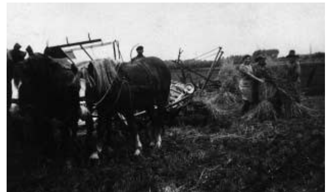
Arbeiten mit der Mähmaschine...
