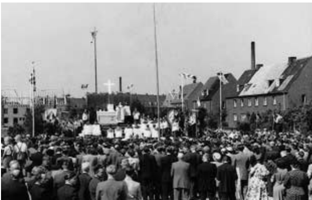
Grundsteinlegung der Ewaldi-Kirche am 6. Juli 1952
