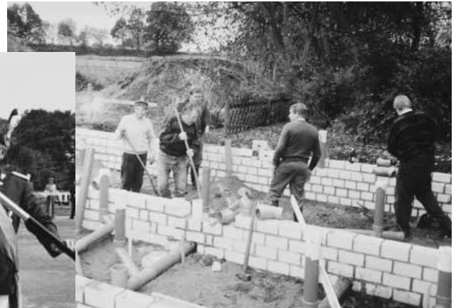
Fundamente, viele Rohre ...
