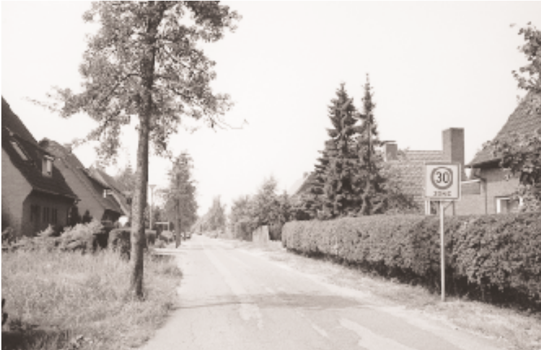
Mittelheggenstraße vor dem Ausbau ...
