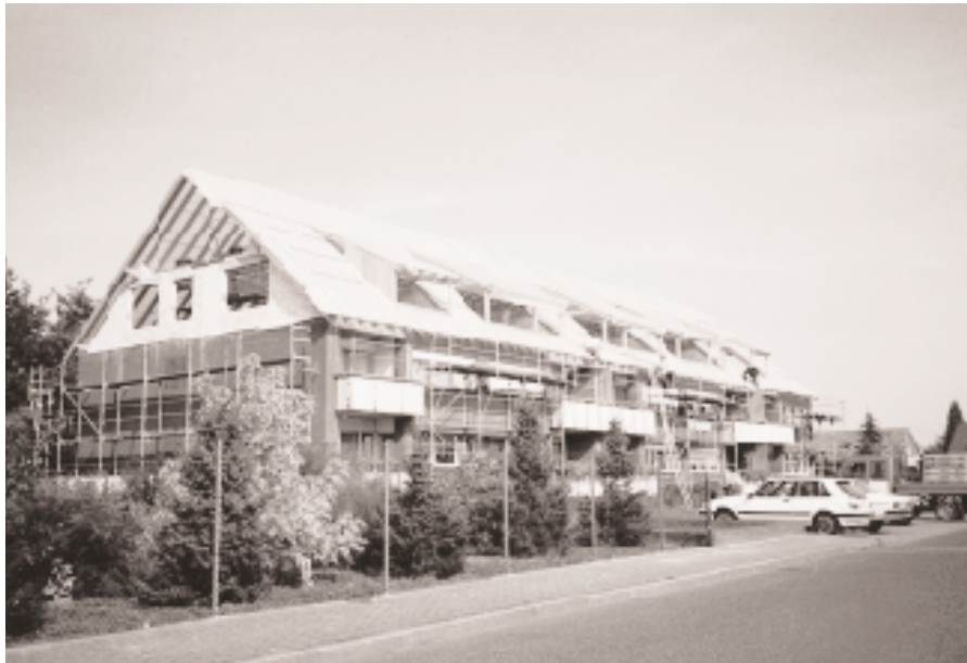
Vom Flachdach zum Spitzdach, Wohnblock an der Straße Im Feld am 17.10.1992
