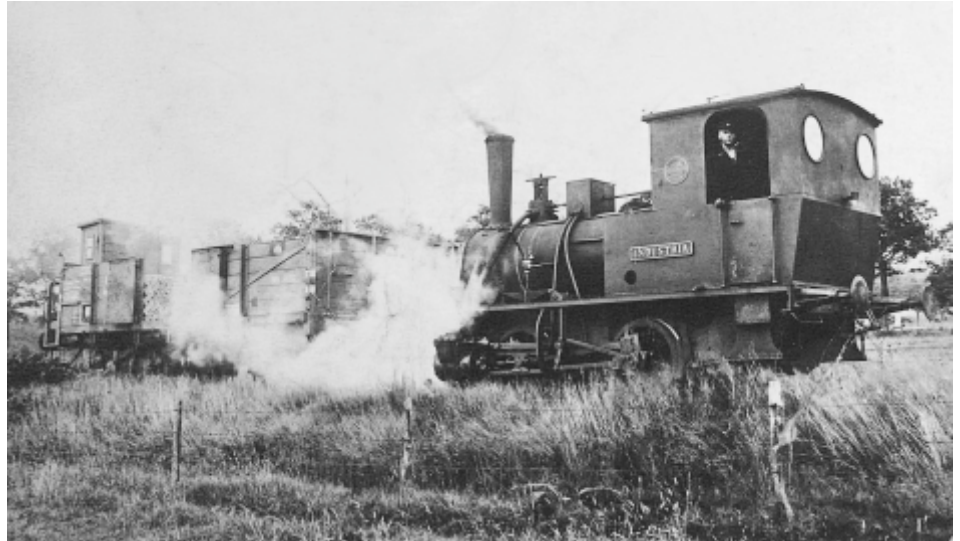
Unter Dampf! Lokführer Weyer mit seiner Dampflokomotive und einem Waggon voll Ziegelsteinen auf dem Anschlußgleis unterwegs zur Strecke Bocholt-Wesel. Auf dem Waggon kann man durch die geöffnete Luke die Ziegelsteine erkennen. Um Beschädigungen an den Steinen zu vermeiden, wurden die Steine im Zick-Zack System auf den Waggonen verpackt. Die Lok war eine typische Industrielok für Werksbahnen, am Waggon erkennt man an der Stirnseite noch ein Bremserhäuschen.
